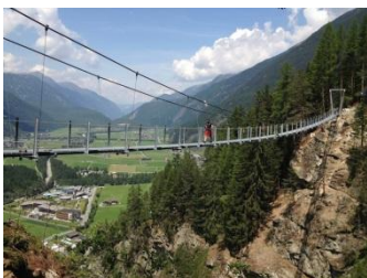
Hängebrücke em Längenfeld
